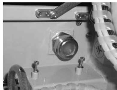
Отверстие под кабели коммуникаций
