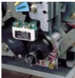
Двигатель натяжения пружин
