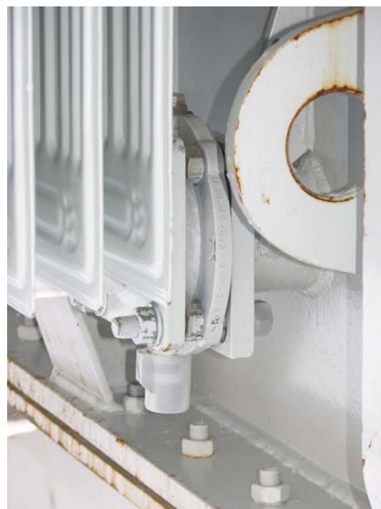
Рисунок 3. Открытое положение шибера радиатора.
