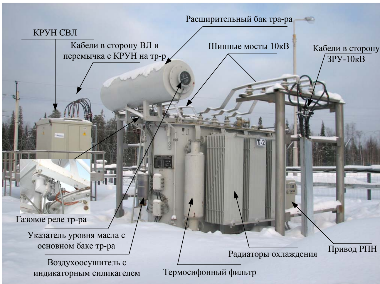
Рисунок 1. Разделительный трансформатор.
